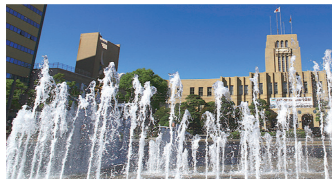
鹿児島市役所本庁舎本館 [A]
